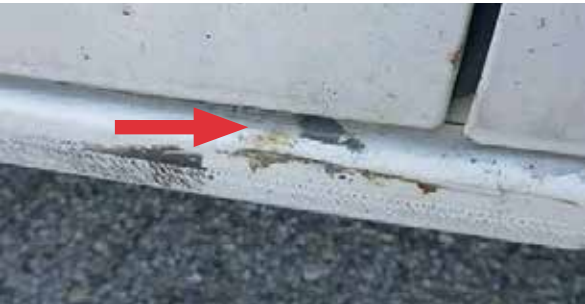
Oštećena boja na okviru vrata
