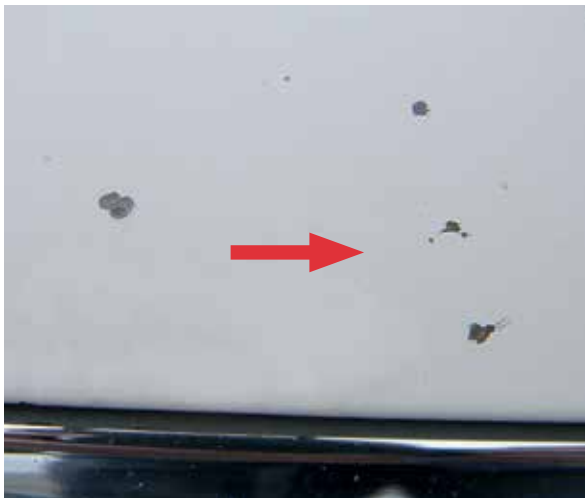
Više udara kamenom na površini 10 x 10 cm
