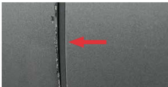
Oštećenje laka > 3 cm
