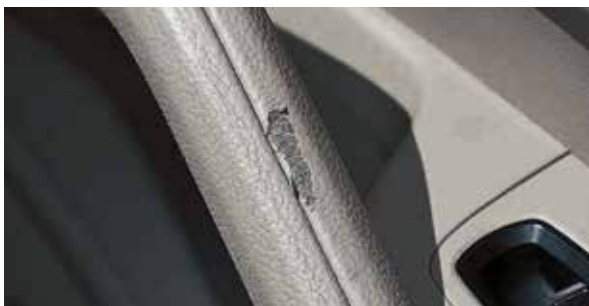
Oštećena obloga vrata
